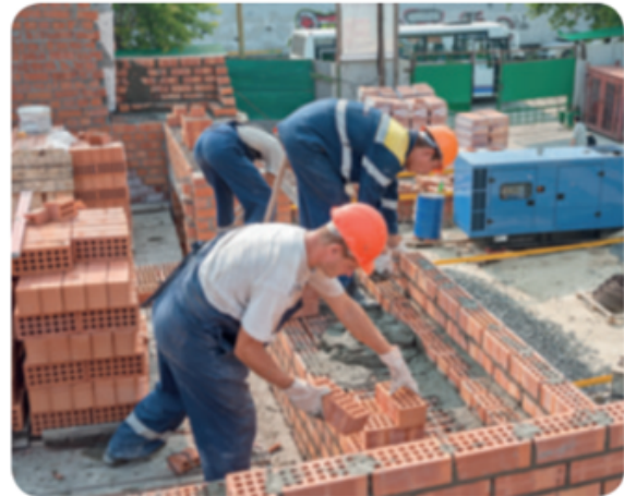
2. En la construcción trabajan muchas personas; por ejemplo, los albañiles.
