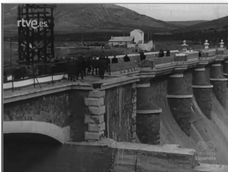
Presa del Guadalén en Vilches (Jaén) inaugurada en el año 1953 (Fotografía extraída del NO-DO)
